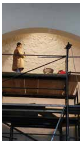
Trabajo en la bóveda
