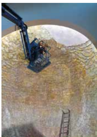
Acabados en la grúa
