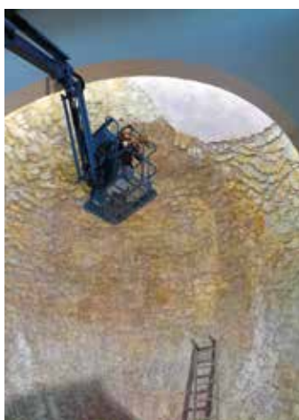
Acabados en la grúa
