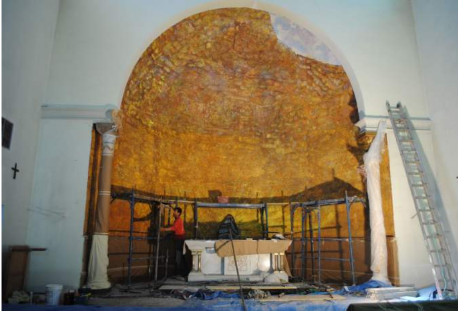
Retirando los andamios
