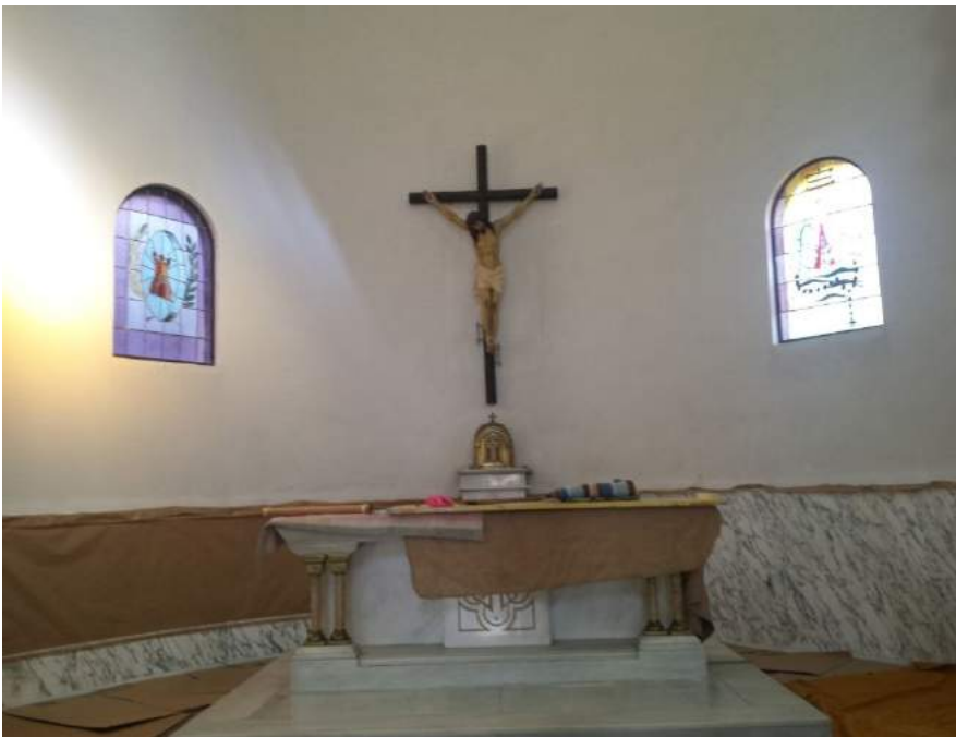
Estado antes de empezar los trabajos
