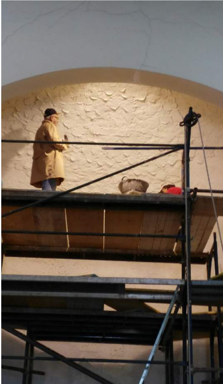
Trabajando en la bóveda.
