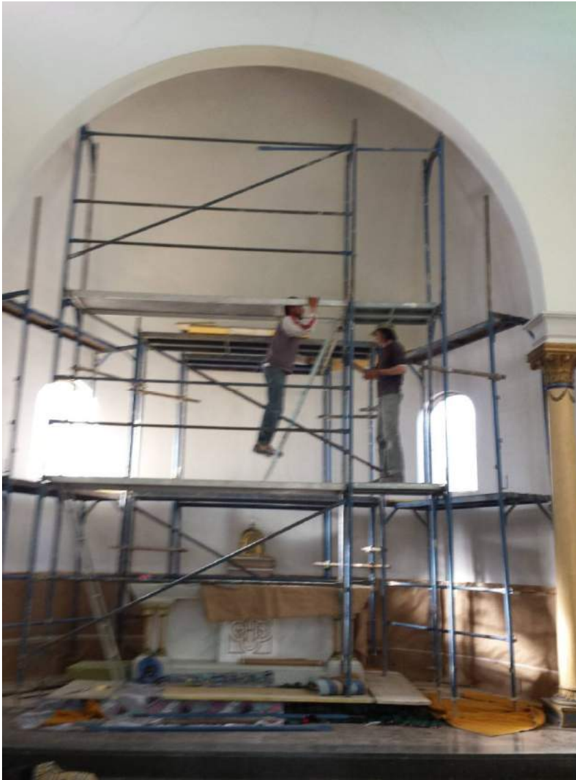
Montando el andamio.
